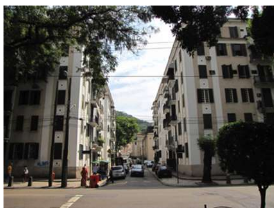
Figura 3 – Edifícios do setor A (6 pavimentos) Fonte: Autores (2010)
