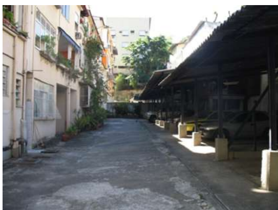
Figura 9 - Estacionamento construído na divisa Leste. Fonte: Autores (2009)
