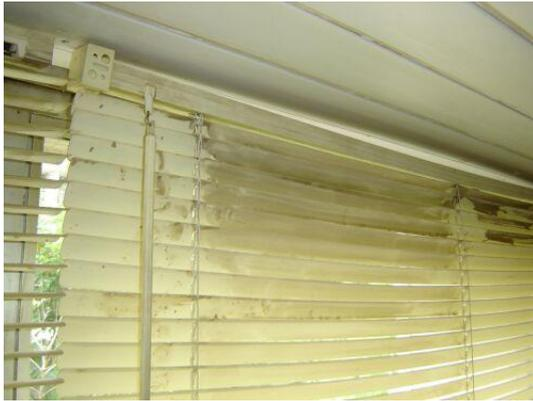
Figura 38- Sala do Coordenador (1º piso). Persianas da janela com necessidade de manutenção ou substituição.
