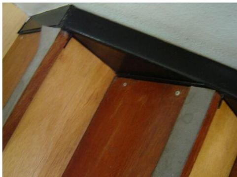
Figura 34- Escada de acesso ao 2º piso. Novo revestimento em madeira: problemas estéticos de estabilidade que geram ruídos e desconforto ao pisar.
