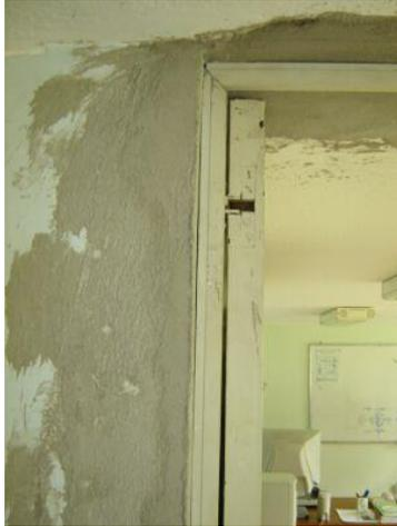
Figura 35- Sala Informática (2º piso). Porta remanejada e revestimento de parede e teto com necessidade de manutenção.
