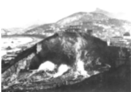
Fig. 197: Desmonte do Morro do Castelo com o uso de jatos d'água bombeados do mar, 1922.
