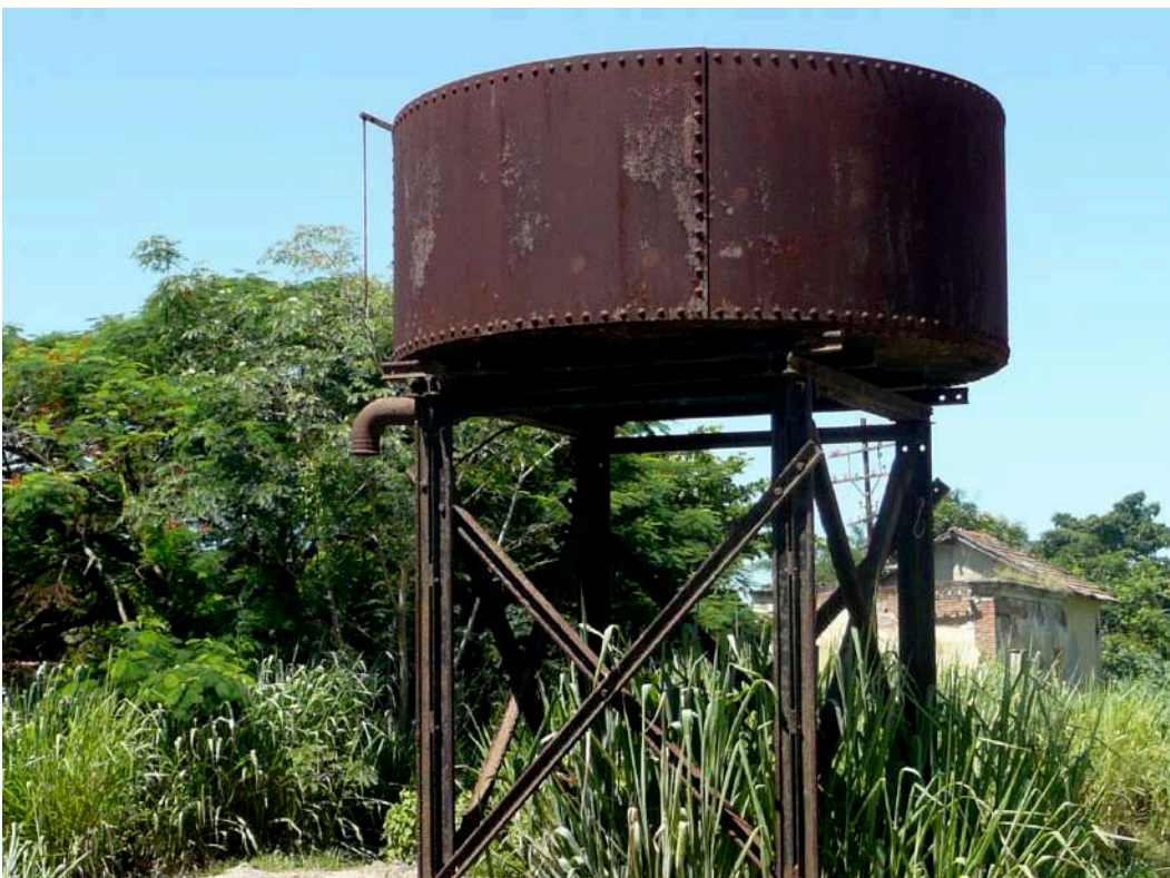
Figura 84: Caixa de armazenamento de água da antiga linha férrea. Fonte: Arquivo próprio, 2012.
