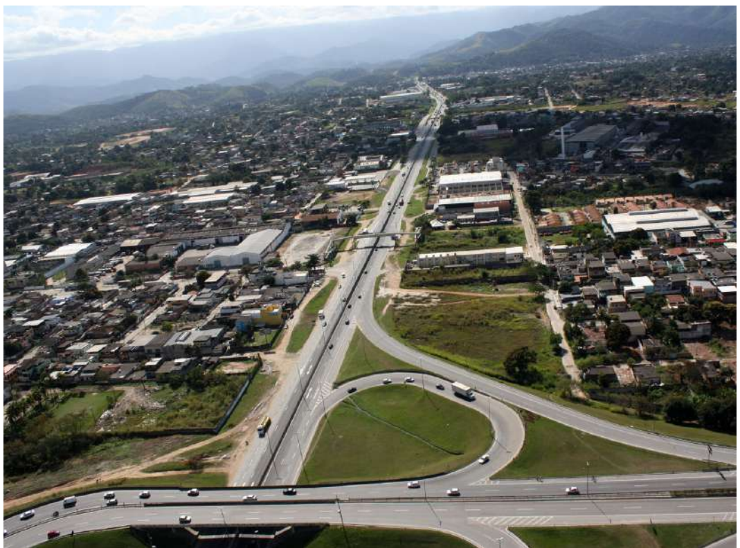
Figura 7: Trecho D, já concluído, cobrindo áreas urbanizadas e áreas por urbanizar - Município de Magé.
