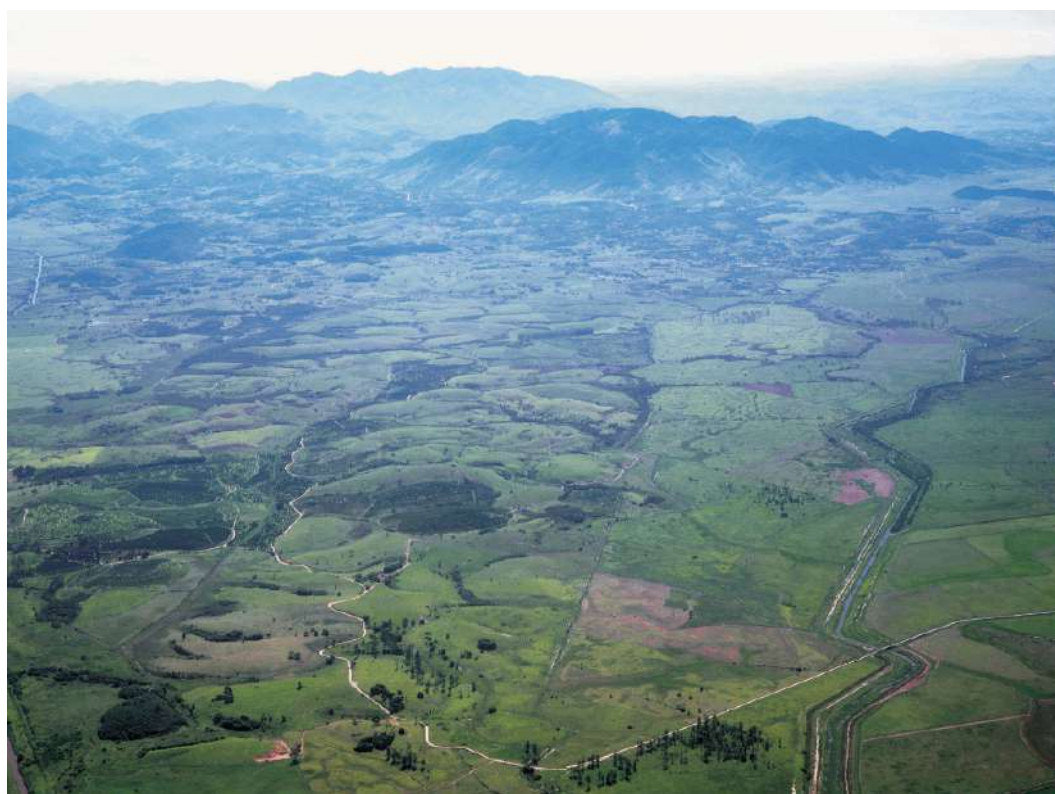
Figura 51: Foto aérea antes das obras de terraplanagem - ano 2007.
