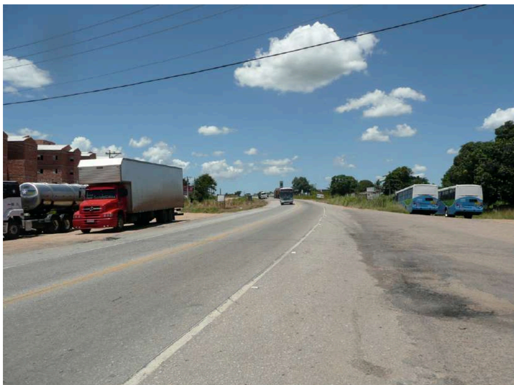
Figura 115: BR-493 Fonte: Arquivo Próprio, 2011.
