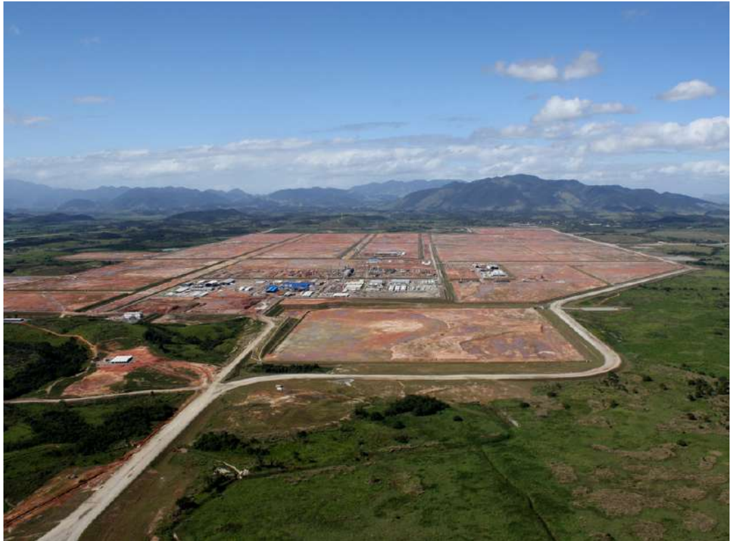
Figura 9: As obras do COMPERJ, no Município de Itaboraí.
