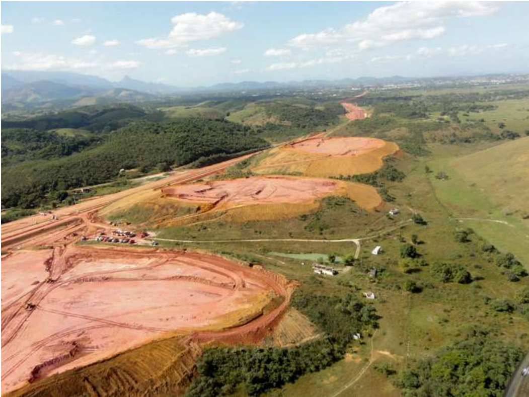
Figura 4: Obras do Arco Metropolitano no Município de Nova Iguaçu. Fonte: Arquivo SEL-RJ, 2011.
