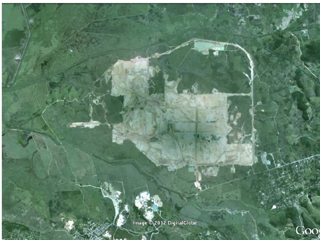
Figura 53: Foto aérea com limite atual da terraplanagem do COMPERJ.
