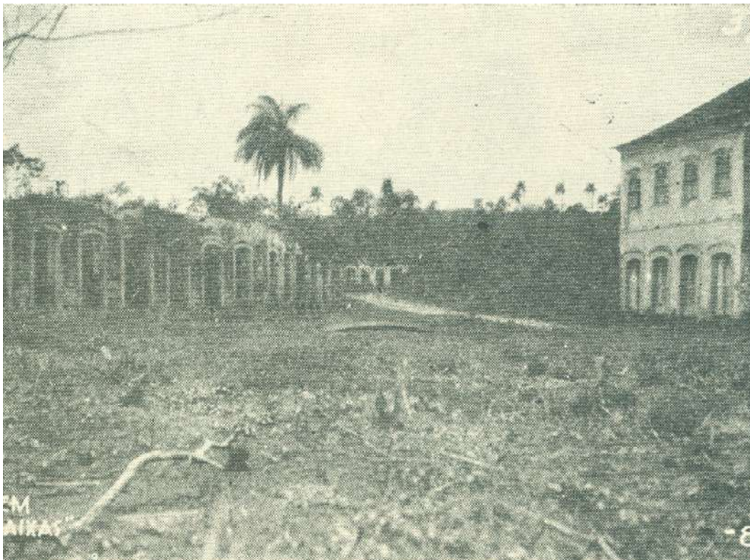
Figura 41: Porto das Caixas.
