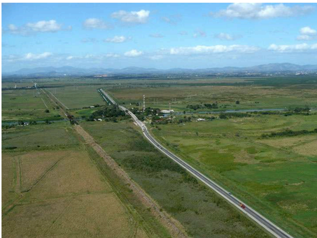
Figura 8: Segmento A do Arco Metropolitano, rodovia BR-493, no Município de Guapimirim, cobrindo áreas planas e com pouca ocupação humana.
