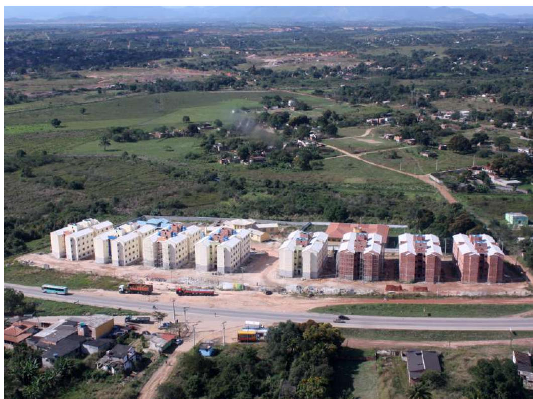
Figura 77: Foto tirada durante a construção. Fevereiro 2011.
