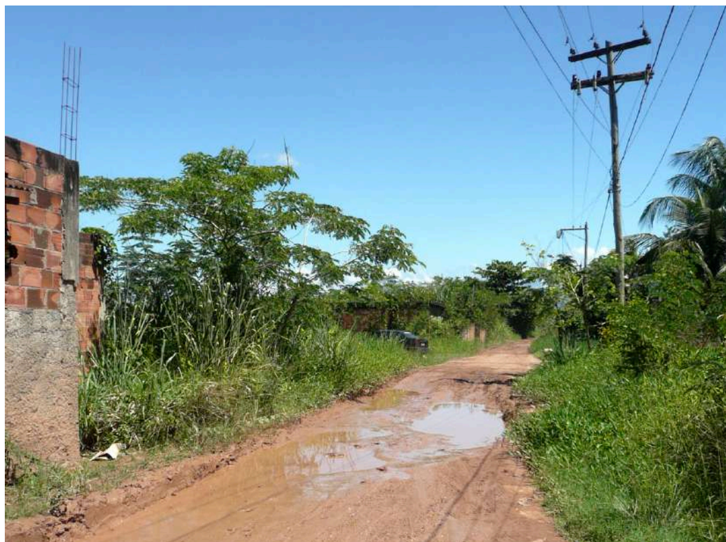
Figura 117: Rua sem pavimentação.
